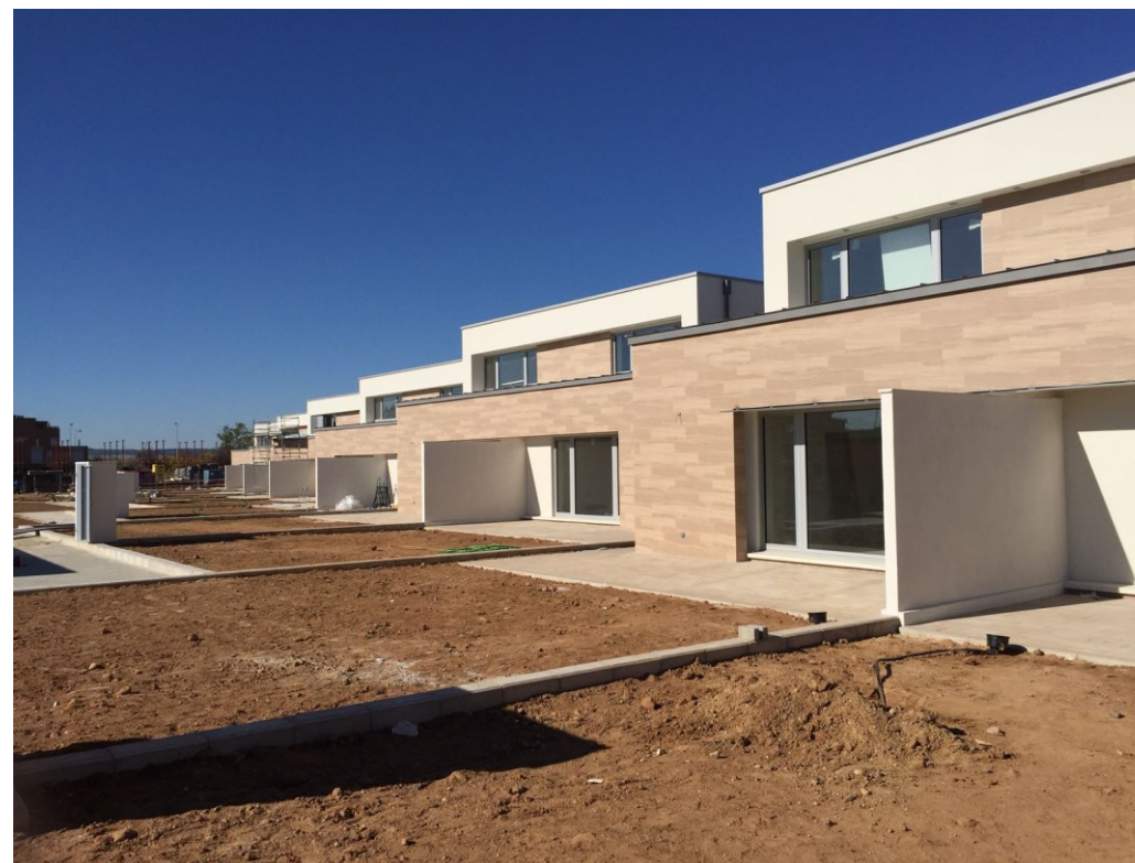
VIVIENDA CTE REALIZADA CON CALDERA DE GAS
