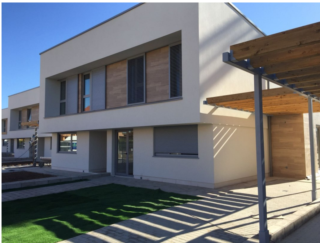
VIVIENDA PASSIVHAUS REALIZADA CON AEROTERMIA
