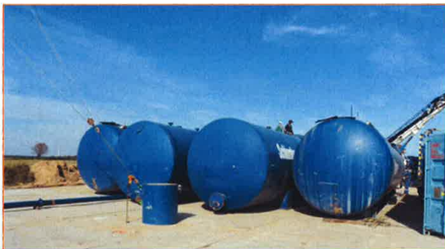
Depósitos de almacenamiento del fluido de retorno
