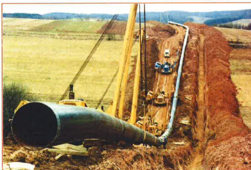
Gasoducto en fase de construcción
