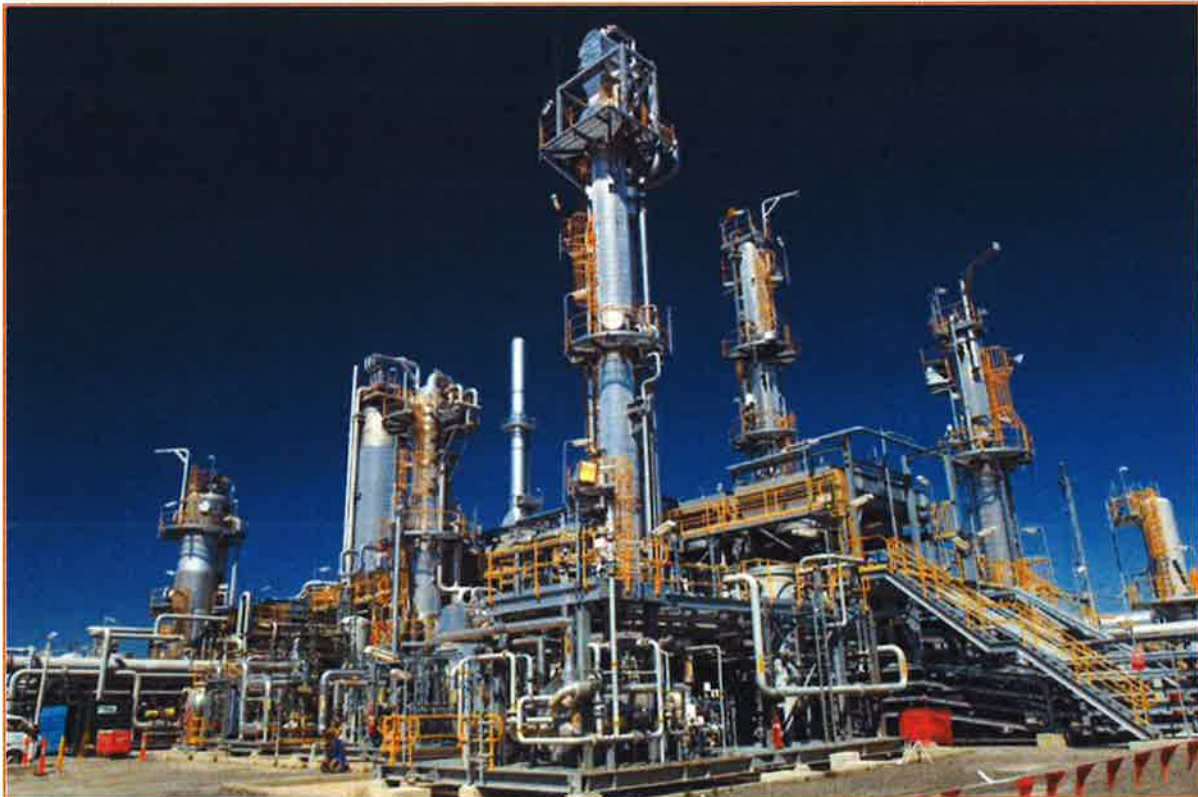
Planta de tratamiento de gas natural
