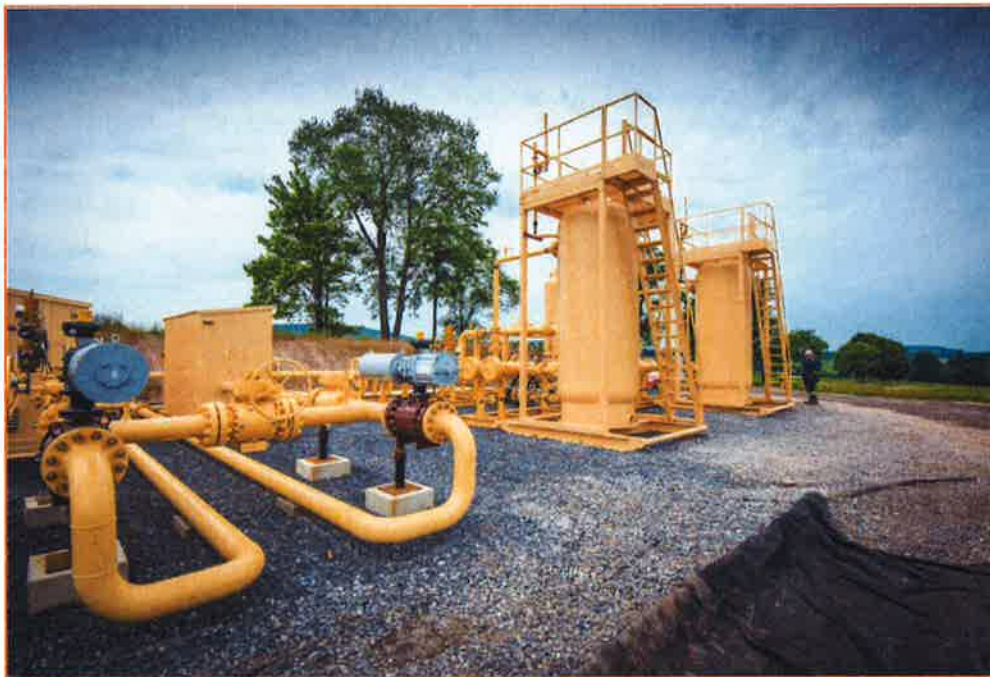
Estación de compresión de gas
