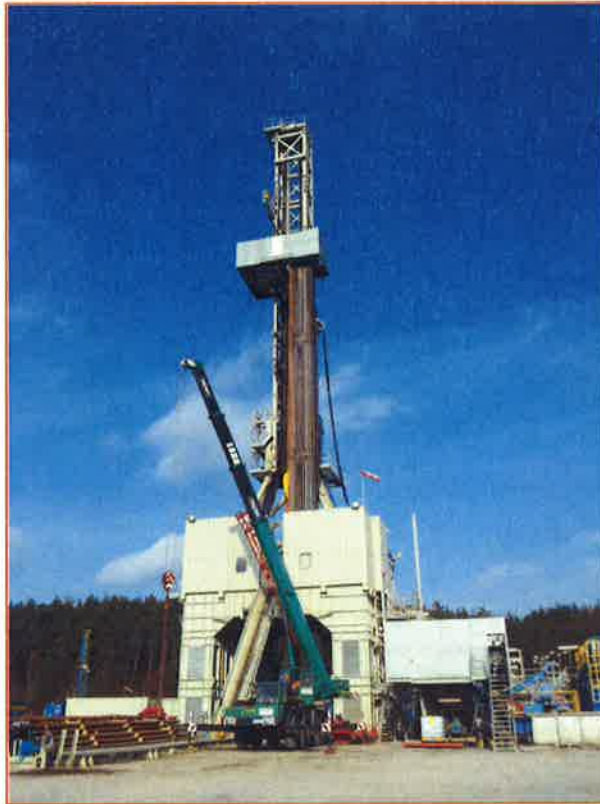
Torre de perforación. Pozo en Polonia
