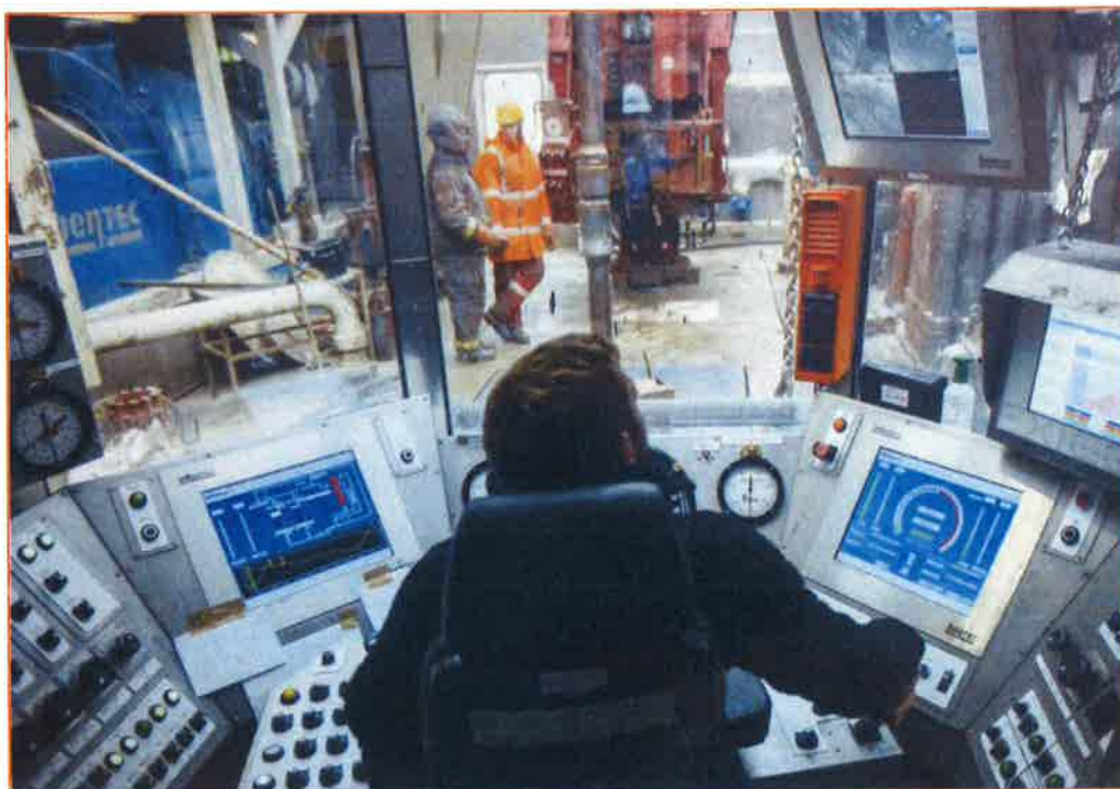
Cabina de control de perforación. Polonia
