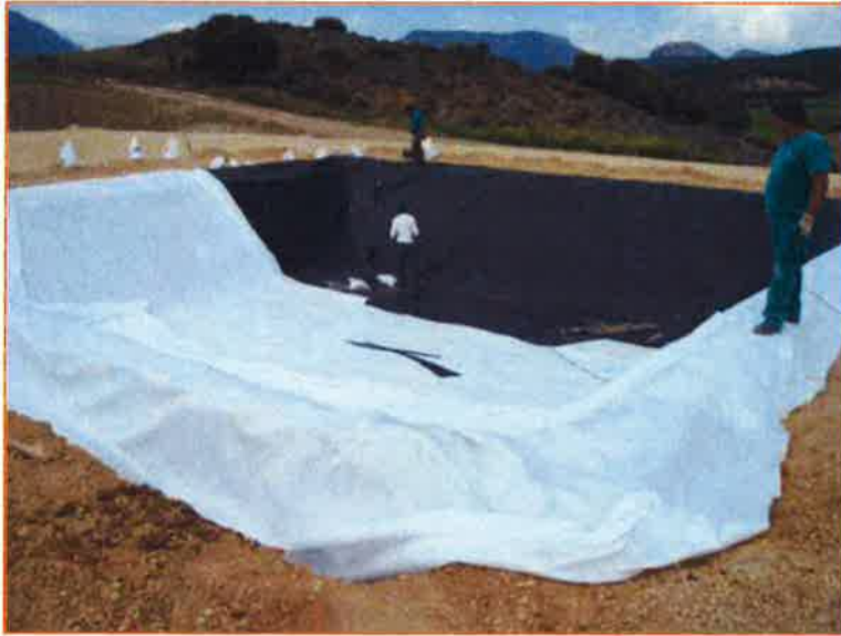
Impermeabilización con geotextil de balsas de agua. Estela-1 en el País Vasco
